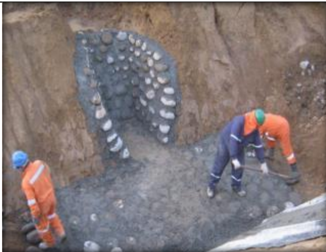
Descarga de quebrada Tipo1.
