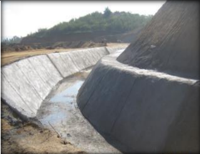
Hormigonado de canal, Km 37,420.
