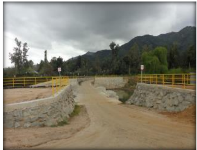
Vista panorámica Bocatoma Canal Lolol Sur.
