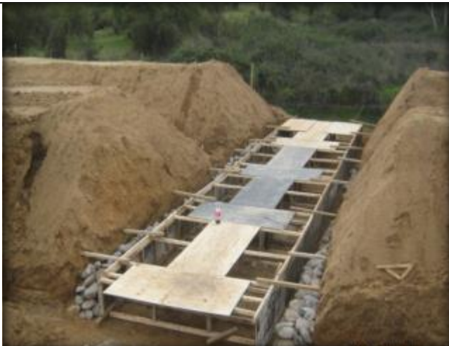
Moldaje y construcción de cruce de quebrada Tipo CQ7, Km 24,628.
