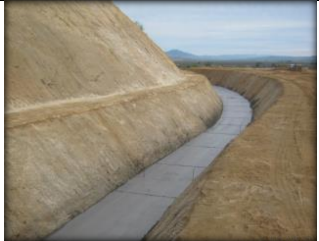
Hormigonado de radier, Km 37,200.
