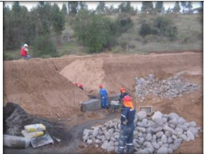
Moldaje y construcción de cruce de quebrada Tipo CQ7, Km 24,628.
