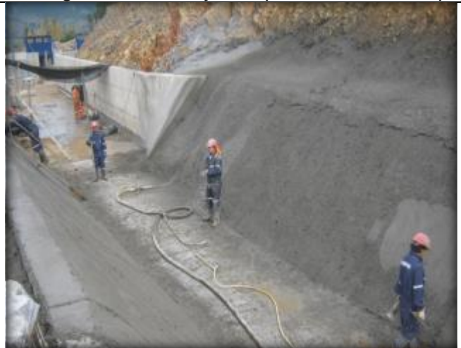
Hormigonado de talud y radier, empalme a obra de toma de Sifón Nerquihue.
