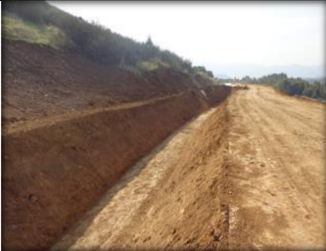
Corte de canal, Km 12,140.
