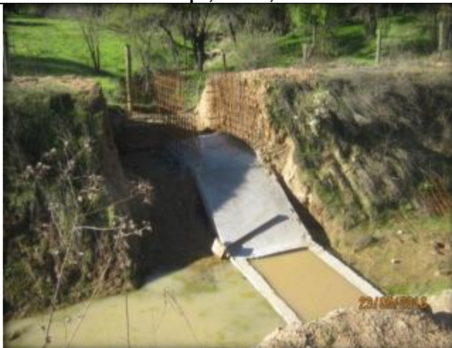
Descarga de quebrada Tipo 1, Km 17,721.
