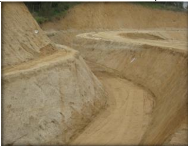
Sello para hormigonado de canal, Km 37,140.
