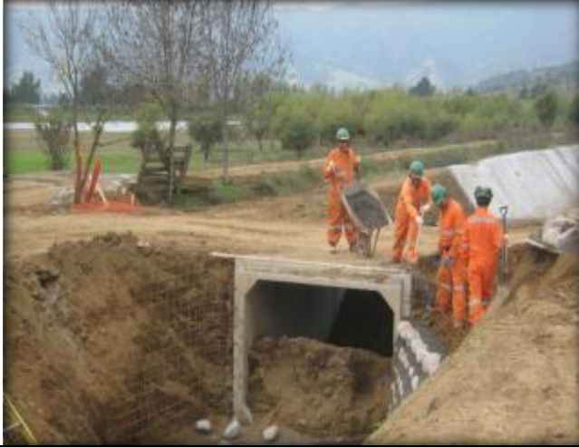
Mampostería de paso predial, Km 1,520.
