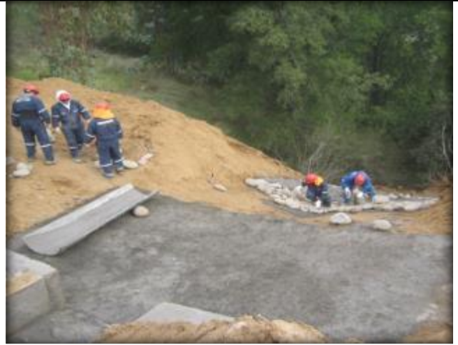
Mampostería para cruce de quebrada Tipo CQ7, Km 24,628.
