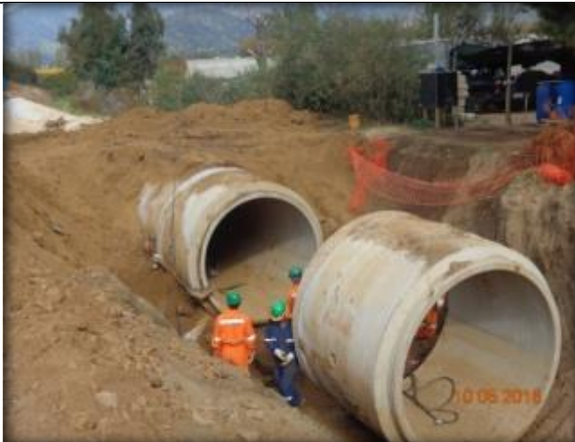
Montaje de tubo para desagüe N°1.
