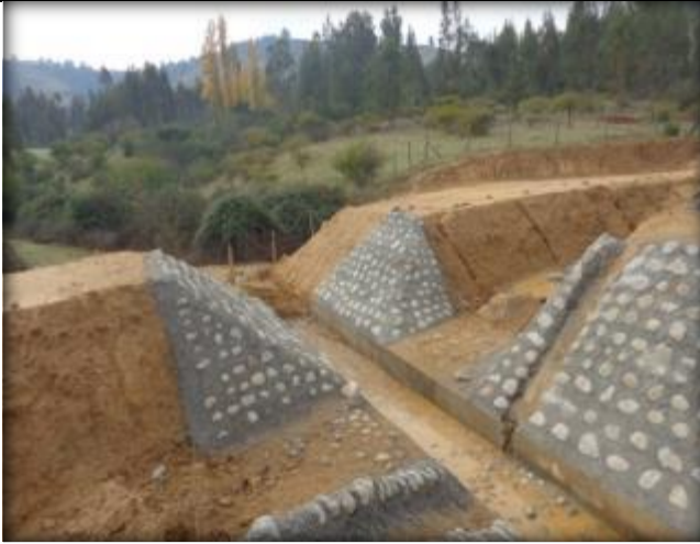
Mampostería para cruce de quebrada Tipo CQ7, Km 24,628.
