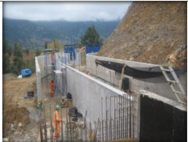
Armadura, canal de descarga.
