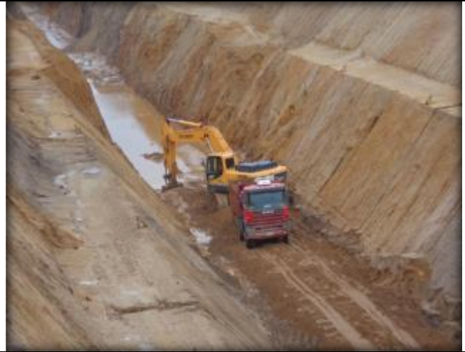
Corte en terreno, Km 28,840.
