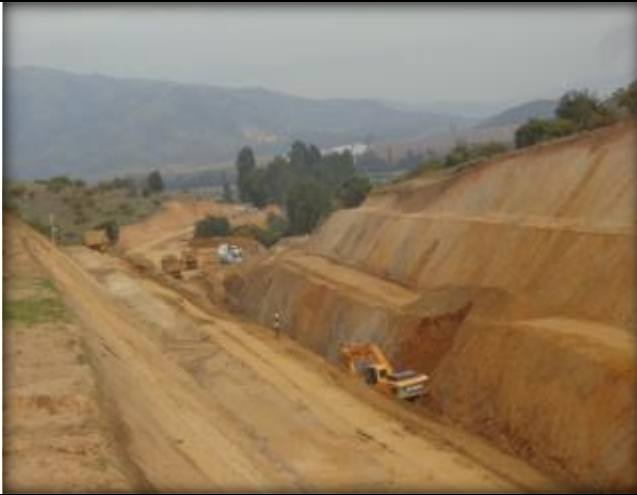
Corte en terreno, Km 21,000.
