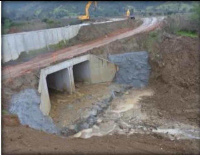
Estero El Guaico, enrocado consolidado.
