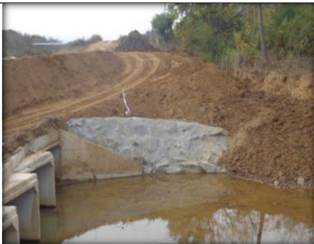
Estero Callihue, enrocado consolidado, entrada.
