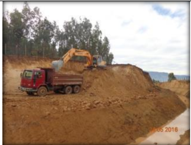
Corte en terreno, Km 22,180.
