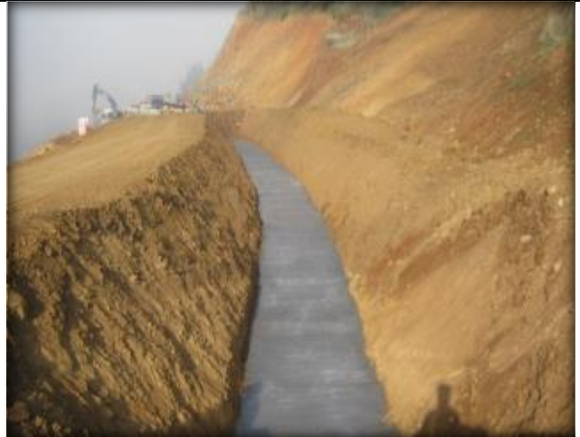
Hormigonado de radier y talud (km 12,140-Km 12,200).
