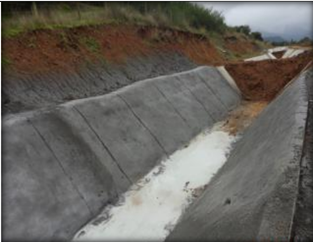
Hormigonado de canal, Km 12,140.
