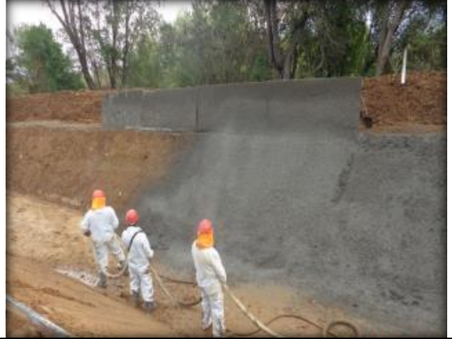
Hormigonado de talud, Km 1,160.
