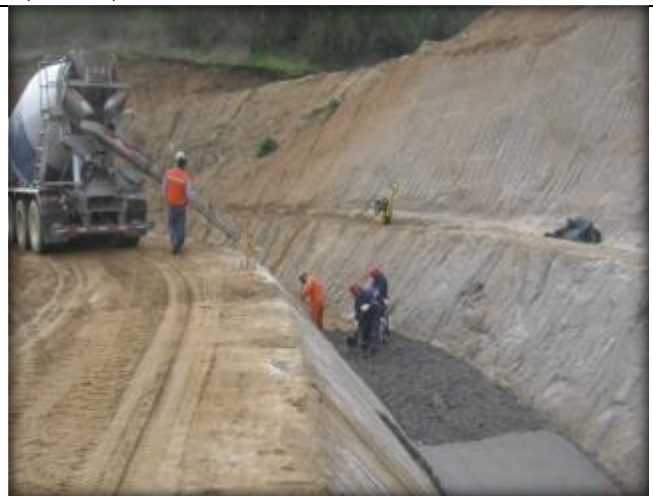
Hormigonado de radier, Km 37,300.
