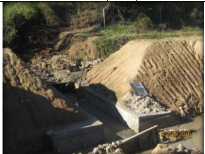
Cruce de quebrada Tipo CQ7, Km 17,540.
