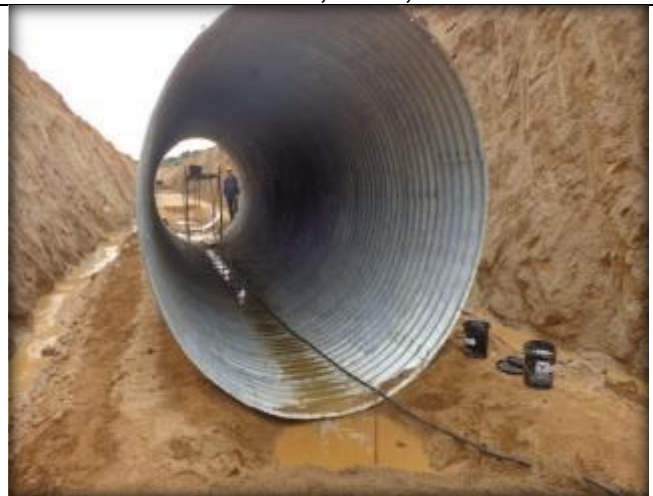
Instalación de tubo corrugado, Km 21,100.
