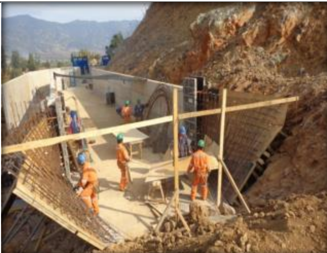
Enfierradura para alas de entrada, Km 12,240.
