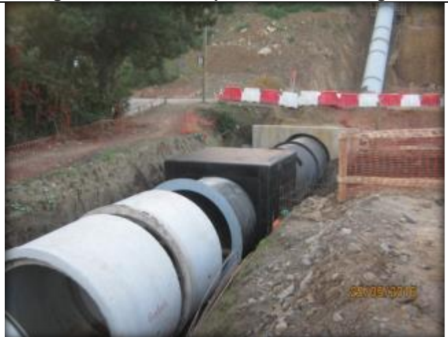
Cámara desagüe N°1.
