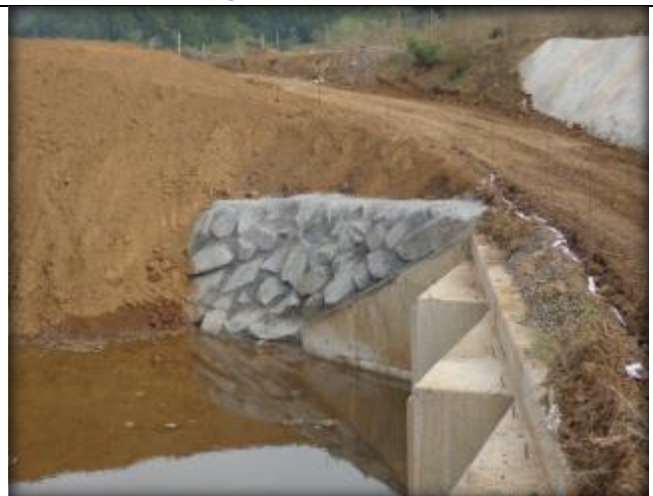
Estero Callihue, enrocado consolidado, salida.
