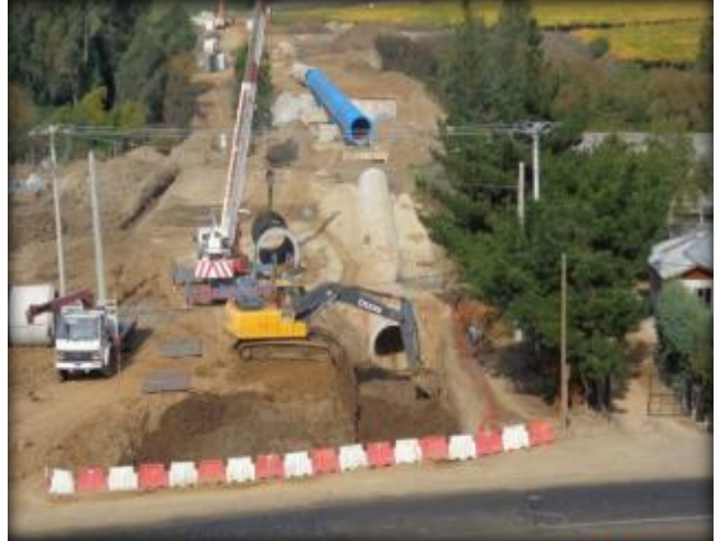
Vista general, excavación para cámara de desagüe N°1.
