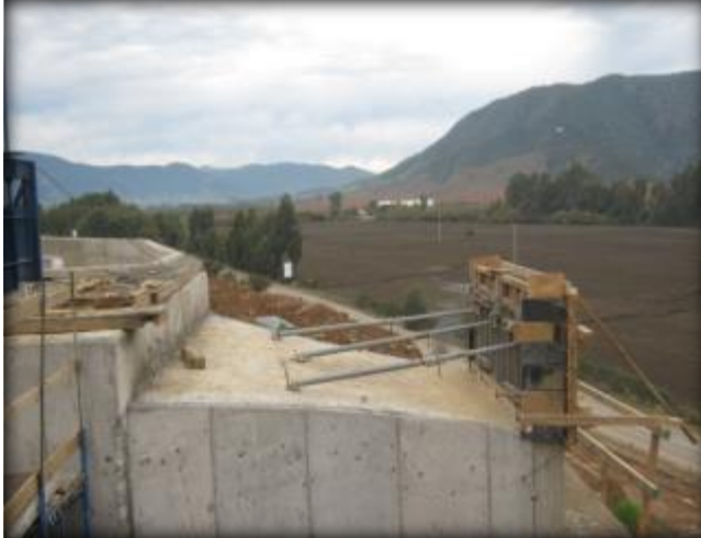
Moldaje de muros guardarruedas.
