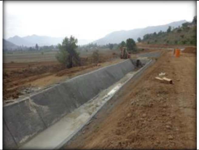
Hormigonado de canal, Km 0,340.
