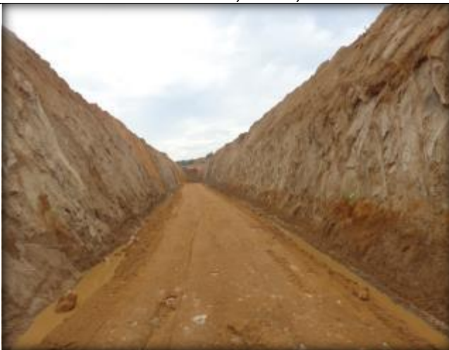
Preparación de sello para tubo corrugado, Km 21,100.
