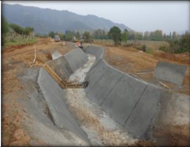
Hormigonado de canal, Km 0,340.
