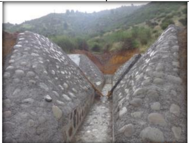
Construcción de quebrada Tipo CQ7, Km 9,825.
