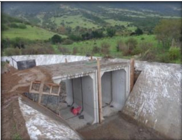
Construcción de paso predial, Km 9,742.
