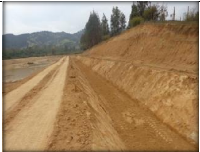
Corte de canal, Km 27,400.
